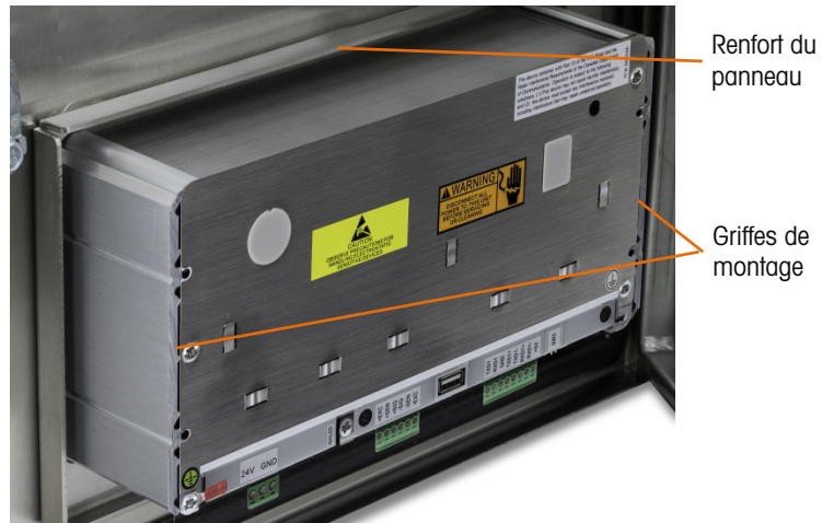
Figure 2-6: Renfort du panneau installé
