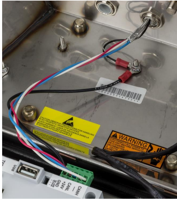
图 A38: 线缆接入仪表插芯完成内部接线
