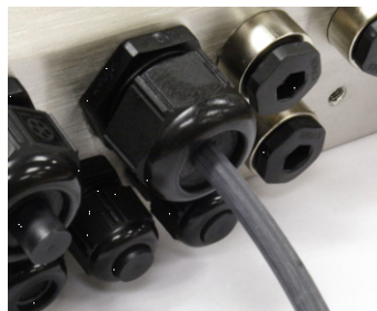
Figura 2-28: Aperto de cabos montado
