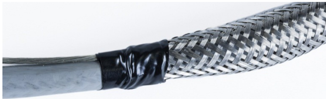
Abbildung 2-54: Äußerer Kabelmantel, mit Isolierband befestigt
