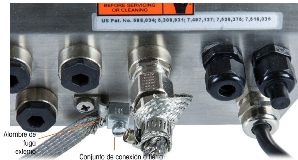
Figura 2-65: Conjunto de cable y cinta instalado en caja para ambientes adversos
