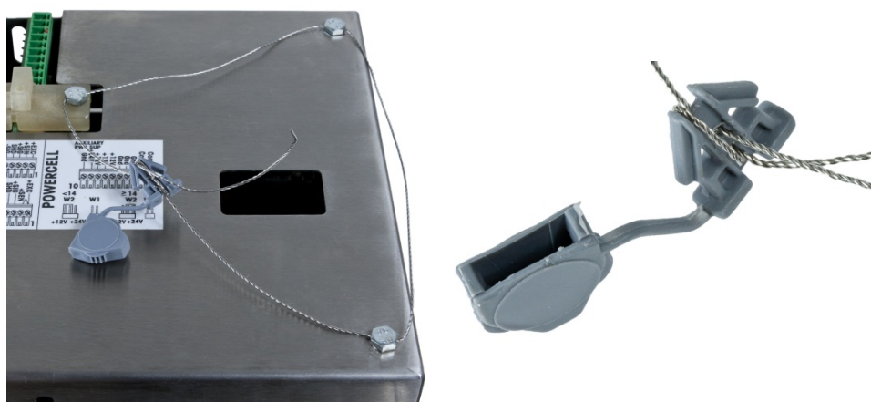
Figura 2-117: Cavo di sigillatura installato, cavo filettato mediante sigillo
