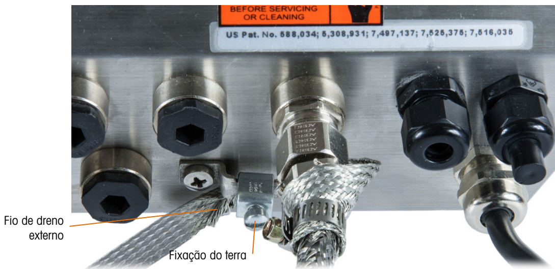
Figura 2-65: Conjunto de cabos e faixa instalados no gabinete para ambiente adverso
